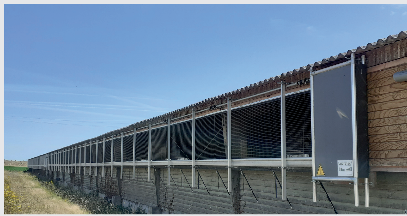
Chèvrerie équipée d'un rideau enroulable
