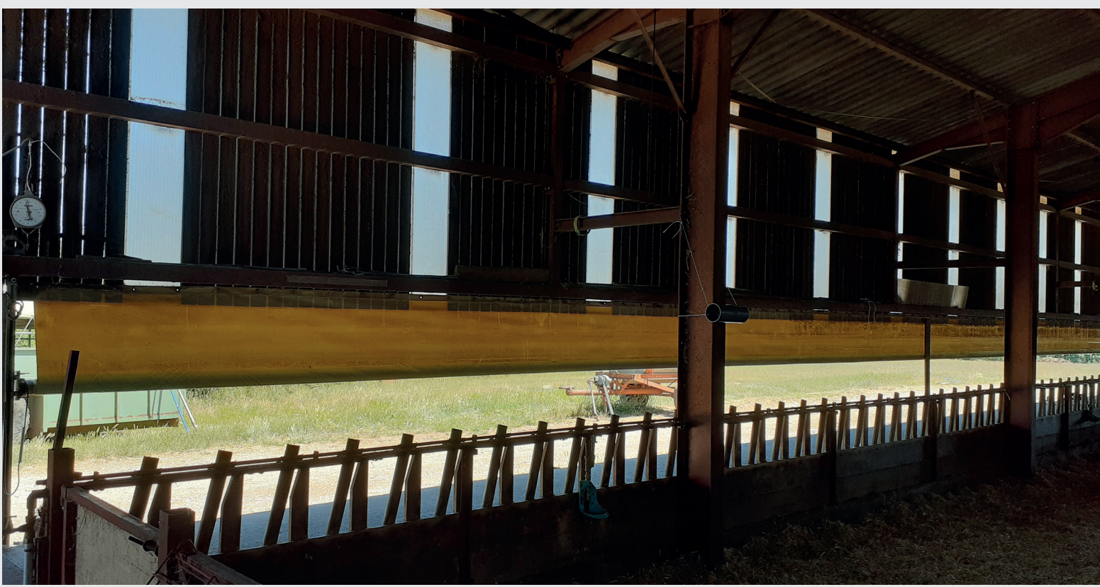
Bergerie équipée de rideaux enroulables en partie basse
