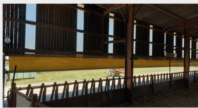
Bergerie équipée de rideaux enroulables en partie basse
